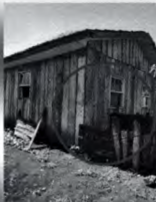
Foto - Local para implantação do Módulo
