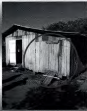
Foto - Local para implantação do Módulo
