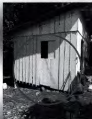
Foto - Local para implantação do Módulo
