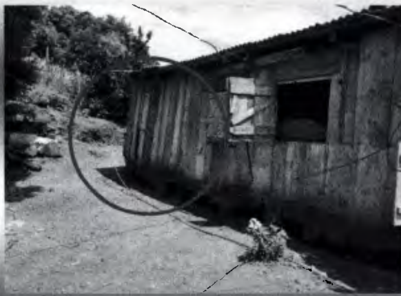
Foto - Local para implantação do Módulo
