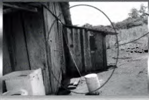
Foto - Local para implantação do Módulo
