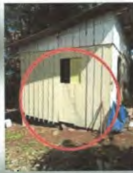
Foto - Local para implantação do Módulo
