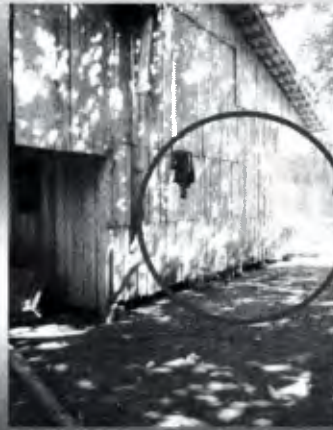
Foto - Local para implantação do Módulo
