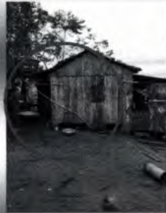
Foto - Local para implantação do Módulo
