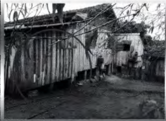
Foto - Local para implantação do Módulo
