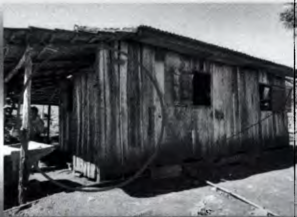
Foto - Local para implantação do Módulo
