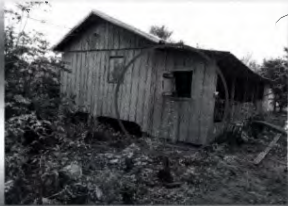
Foto - Local para implantação do Módulo
