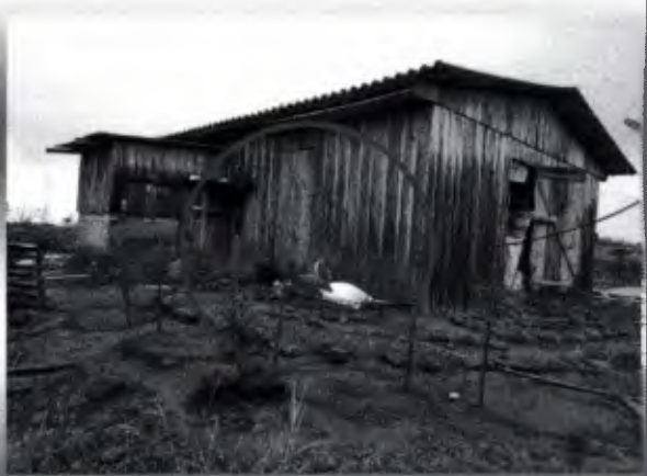
Foto - Local para implantação do Módulo
