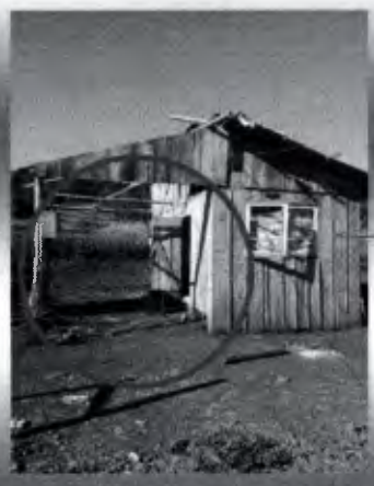
Foto - Local para implantação do Módulo
