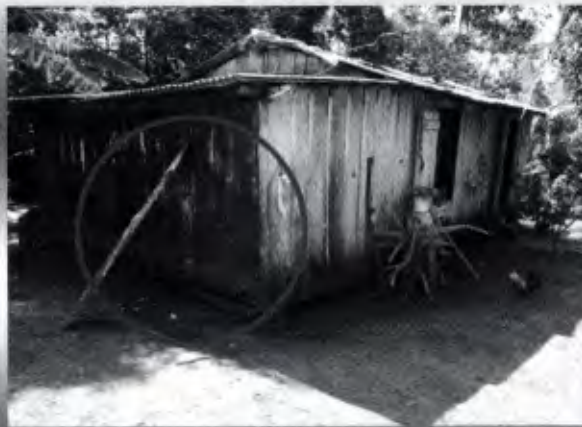
Foto – Local para implantação do Módulo
